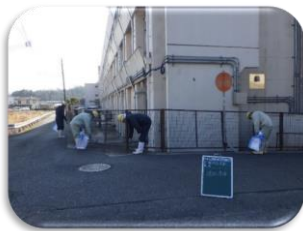
↑ 現場周辺清掃
