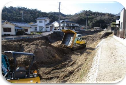
↑ 普通河川高見川河道掘削工事
