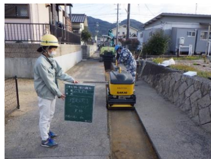
↑ 現場から発生した発生土を再利用
