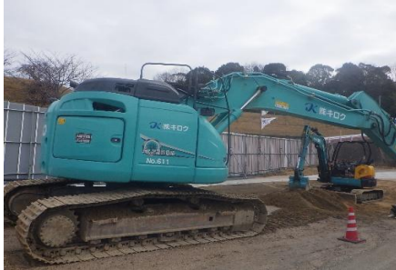
市道熊ヶ浦鯛ノ原線道路改良工事
