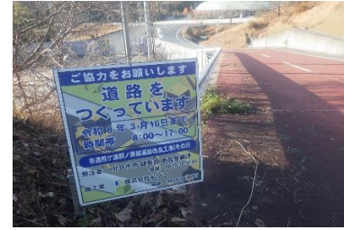
👉 工事周知看板
